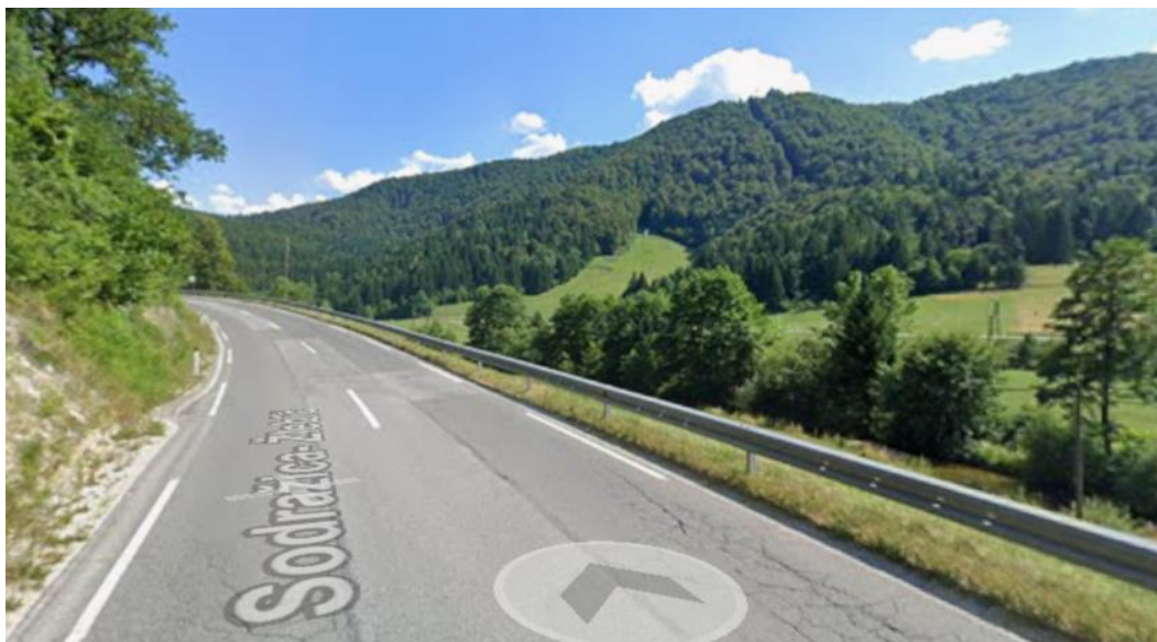
Odsek regionalne ceste R1-212/1120 Sodražica - Zamostec
