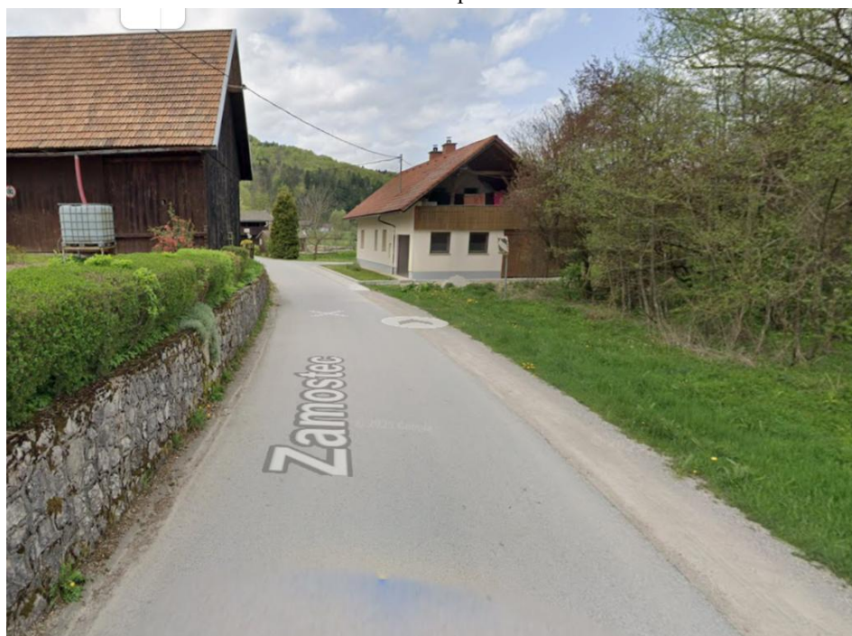
Zoženje v naselju Zamostec in nepregleden potek ceste
